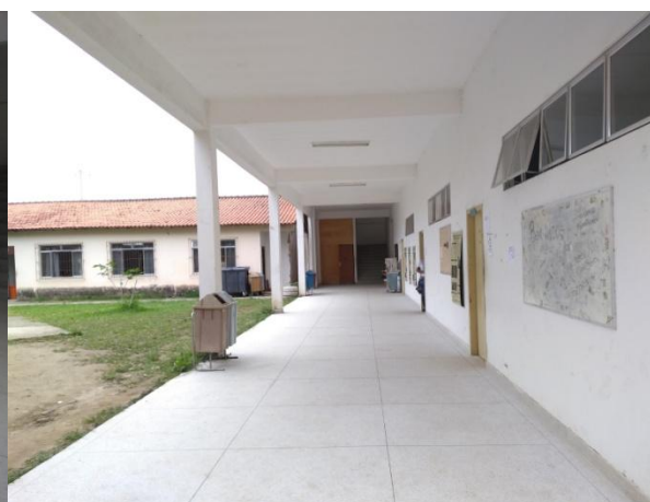
Figura 12. Corredor do prédio de Meio Ambiente
