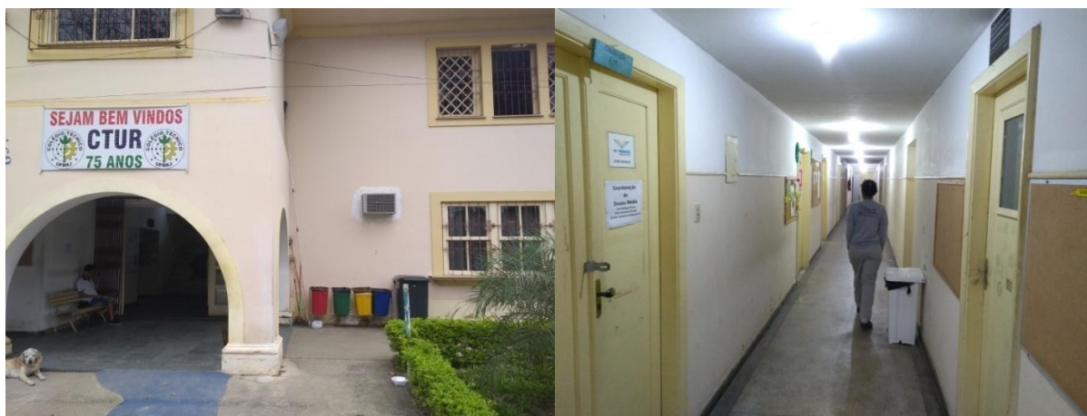
Figura 7. Fachada principal (esquerda) e corredor do primeiro andar (direita) do Prédio Principal.
